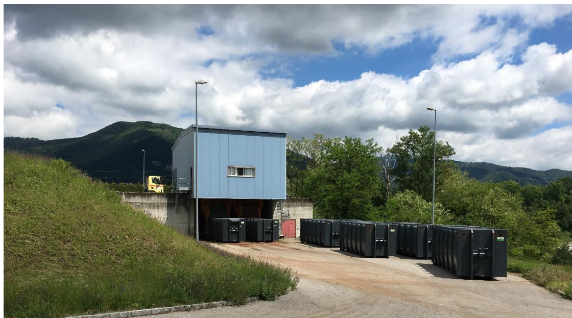
Stazione di trasbordo Valle della Motta
